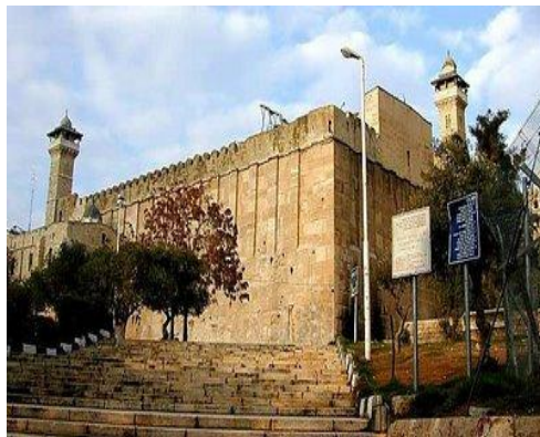
Este es hoy día el Edificio por donde se entra a la Tumba de los Patriarcas, en Hebrón.
